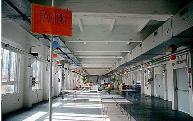
BUSINESS Spazio interno in via di ristrutturazione
